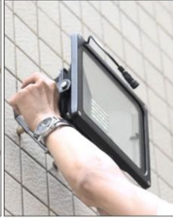
3 灯头墙壁安装 对准灯头支架拧紧螺母
