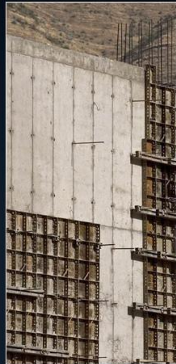
钢筋混凝土墙壁
